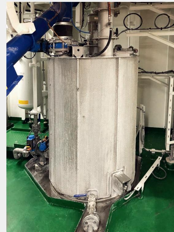
*Узел приготовления суспензии из порошка на судне. Слева — винтовой дозатор для порошка, виброднище и выход конуса, в который растаривается порошок из биг-бэга. Справа — реактор с мешалкой, в котором происходит смешение порошка и воды.*
